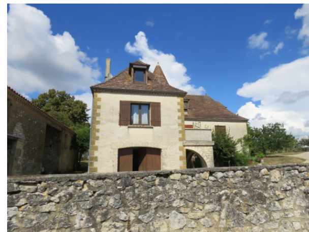
Toiture pentue à coyau d'une maison typique
