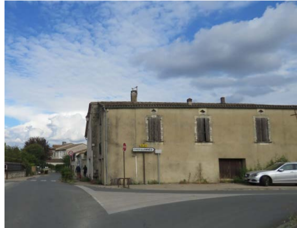
La RD 21 à Issigeac (aire d'étude éloignée)
